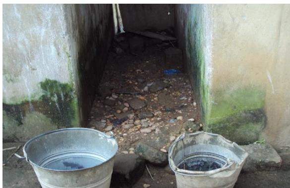
**Photo 2 :** humidité et présence de moisissures au bas des murs dans une habitation à Athiéme
