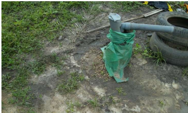
Photo 4 : un forage manuel réalisé pour l'irrigation d'un périmètre de champ à Ahoho
