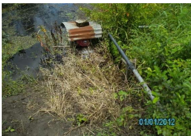
Photo 1 : dispositif de mobilisation d'eau par le biais d'une moto-pompe
