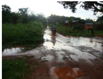
Photo 2: Voie d'accès au CSA de Sèhoun
