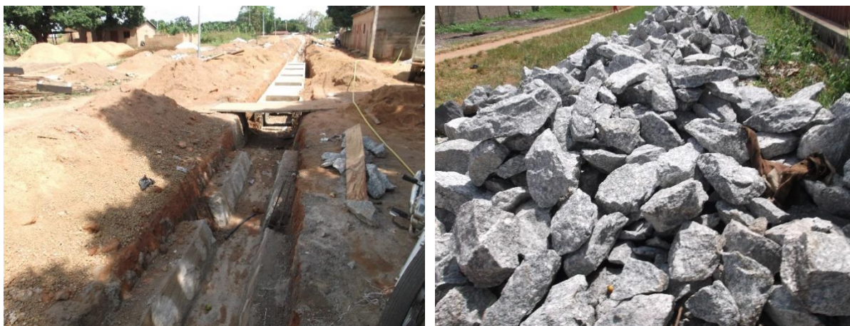
Photo 5 : Construction d'un caniveau avec des blocs de granite
