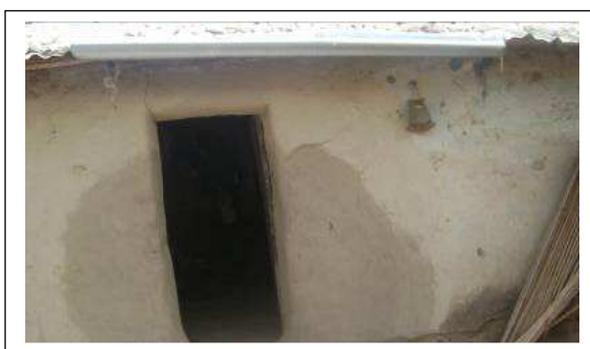
Photo 7: Gouttière servant à récupérer l'eau pluviale
